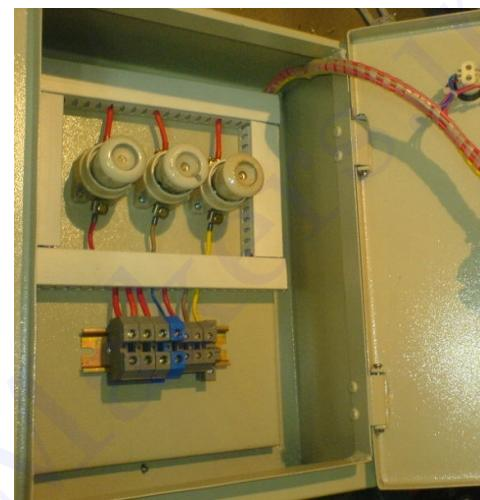
تابلوی بعدی که مدار آن بسته شد تابلوی تک ضرب می باشد که یکی از ساده‌ترین مدارات قدرت و فرمان می باشد که شمای فنی آن و همچنین عکس‌های این تابلو در زیر آمده است فقط به این نکته اشاره می شود مونتاژ تابلو دقیقاً طبق مراحل گفته شده برای تمامی تابلوها می باشد.
